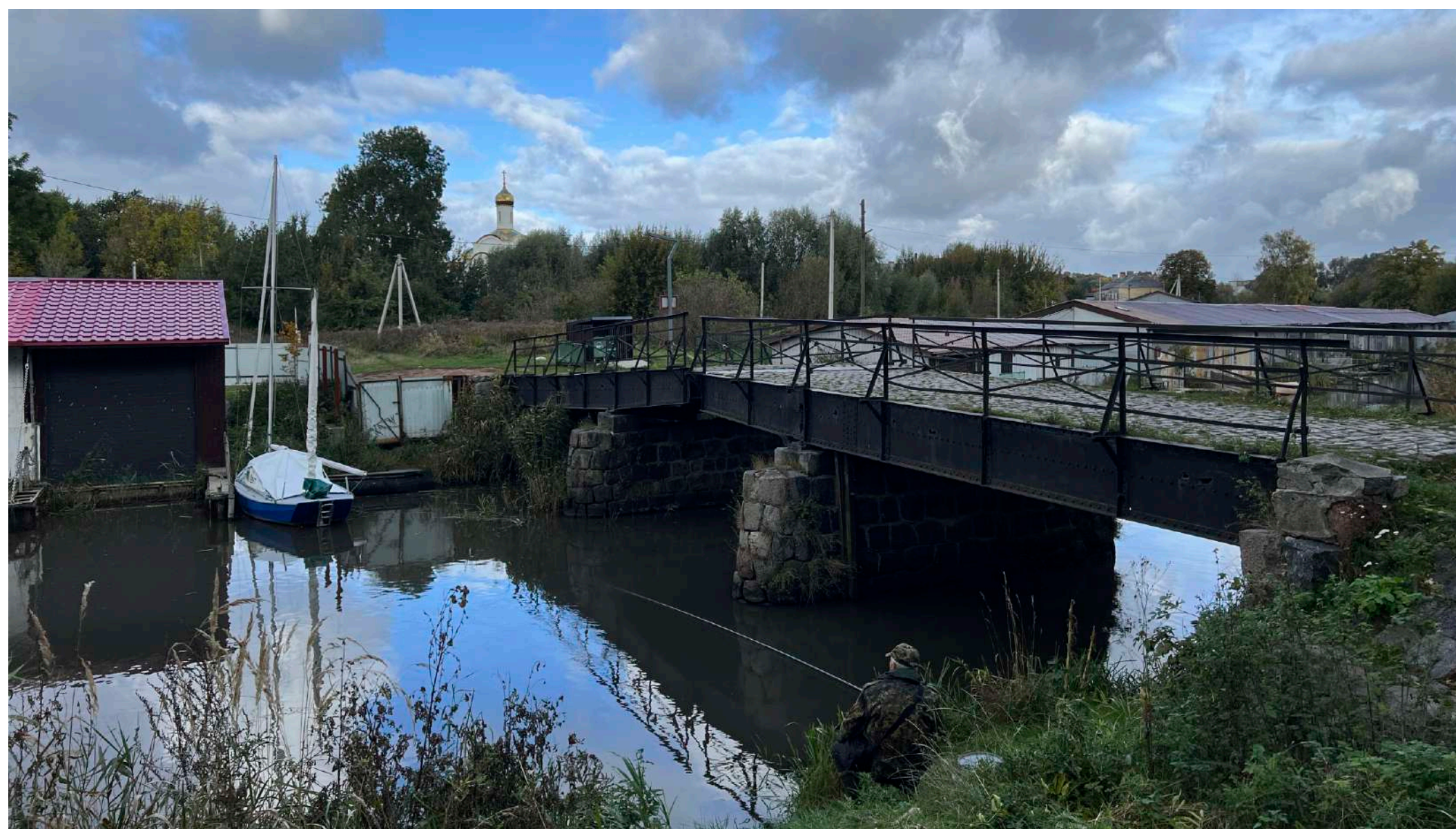
Амтский мост через реку Приморскую. Самый маленький разводной мост, зазор между пролётами в 47 см служит для прохода мачт маломерных судов. Координаты: 54.727399276116245, 20.008031597397878
