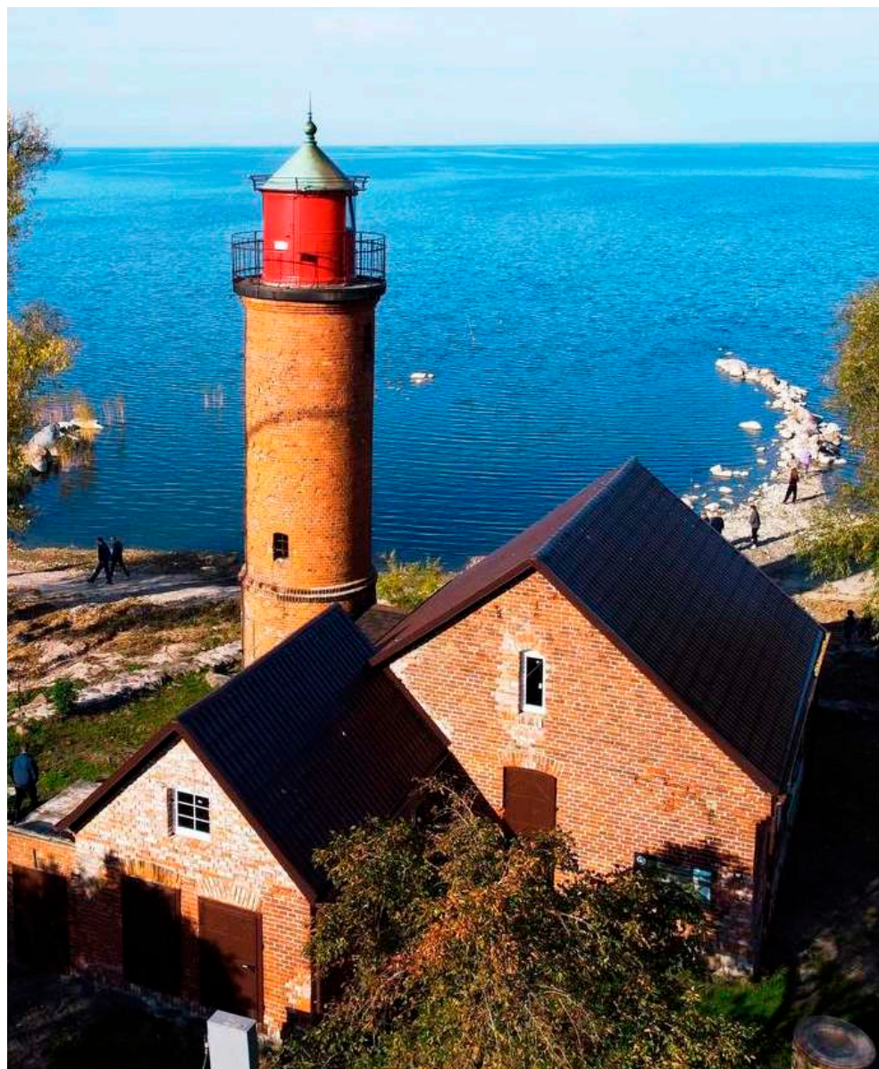
Маяк в Заливино. Начал функционировать в 1868 г. как керосиновый фонарь с линзой, укрепленный на деревянной штанге длиной 12 м. В 1908 г. из кирпича построили маяк высотой 15,3 м. Координаты: 54.902178, 21.058649
